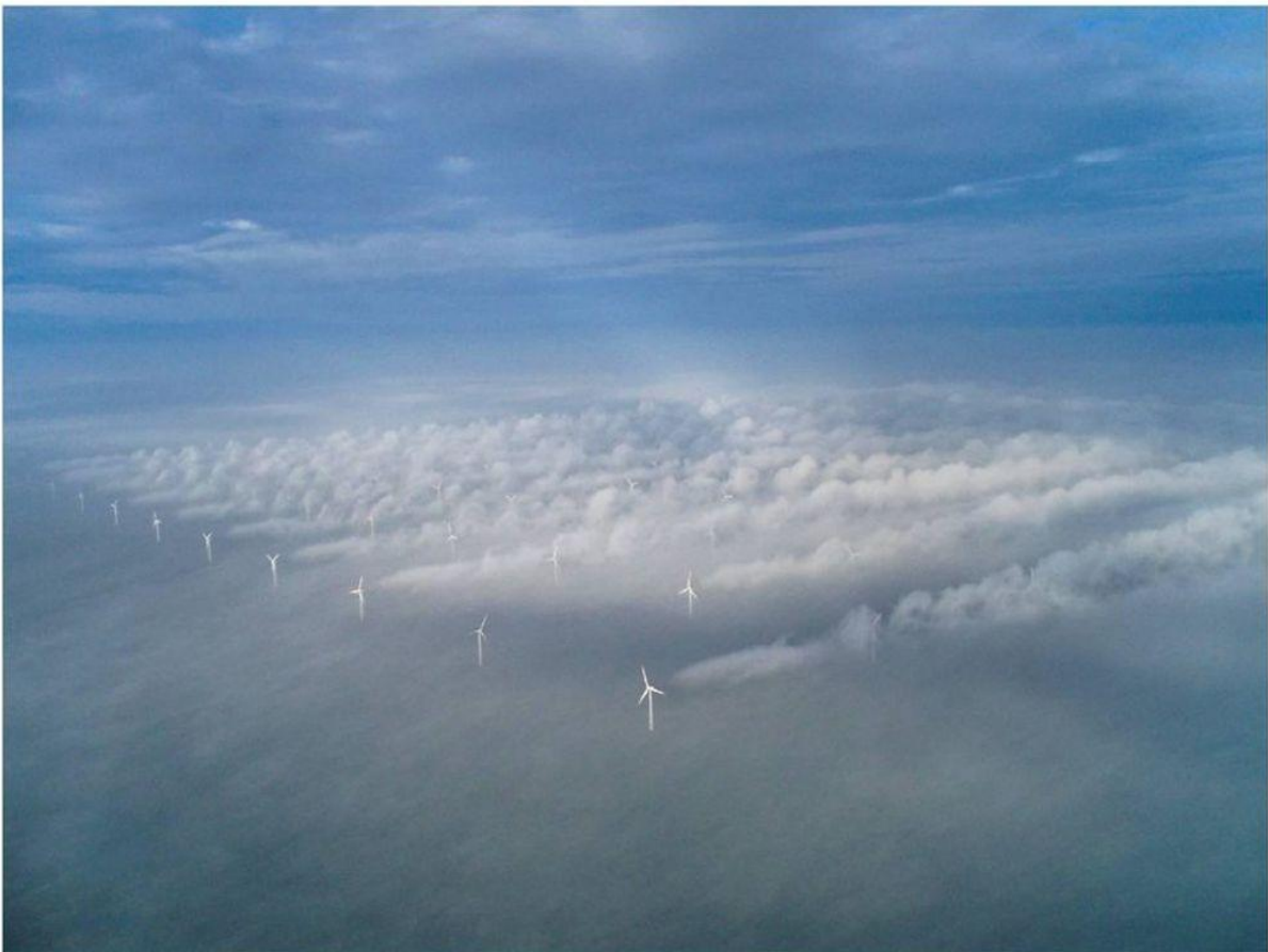
Windpark Horns Rev 1 bij Denemarken. 80 windmolens, onderlinge afstand 500 meter. Ashoogte 70 m, rotor 80 m diameter. Windkracht 6
